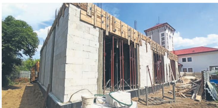
Budowa Biblioteki Publicznej Gminy Nieporęt
